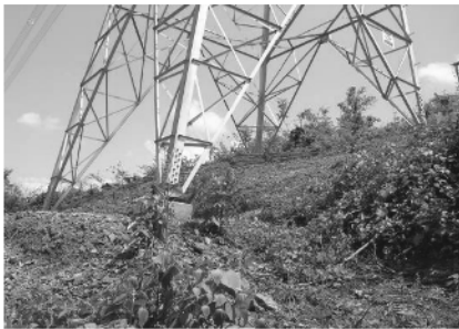
图3 全方位长短腿设计基础施工
